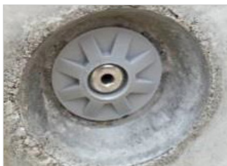
HyDra RiveStop PS efter installation
